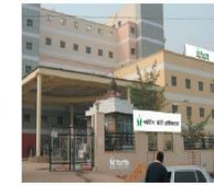
Fortis Modi Hospital, Kota
