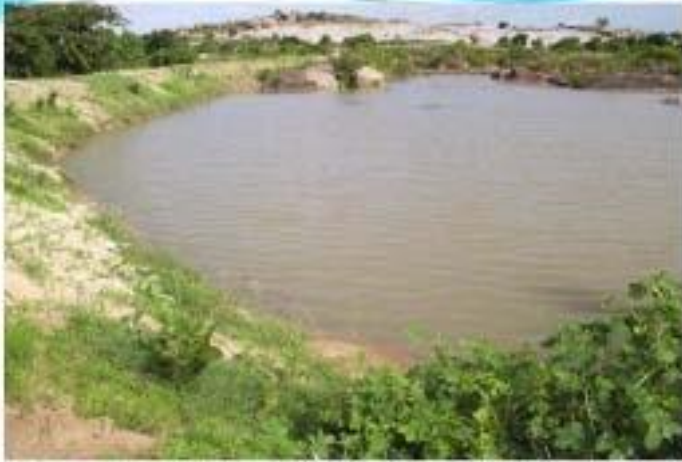
Mini Percolation Tank
